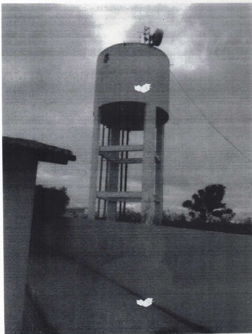
Figura 5 – Reservatório elevado existente
