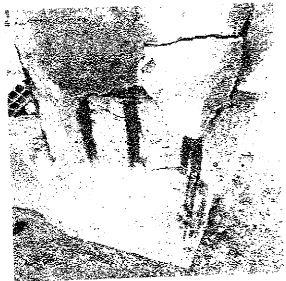
- Pilares de sustentação do reservatório elevado em processo de corrosão avançada.
