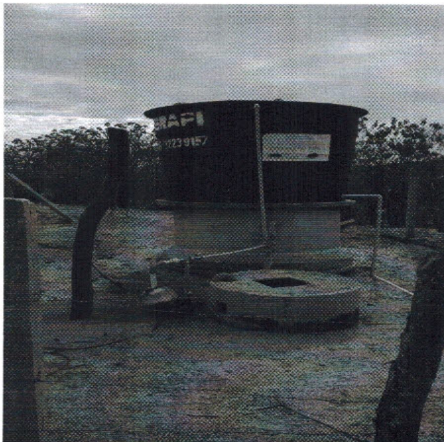
Figura 3 - Poço Profundo desativado e reservatório para captação de água de Carro Pipa
